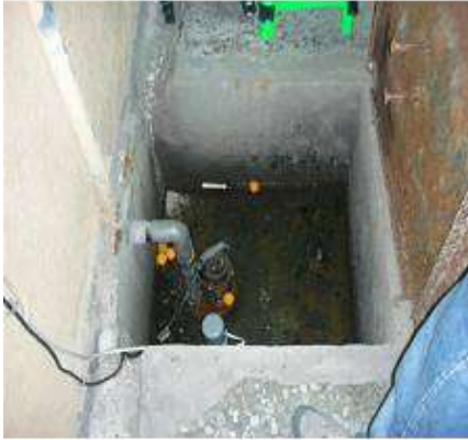
地下室集水槽
