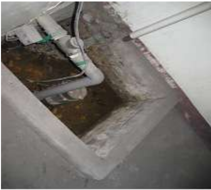
地下室儲水槽
