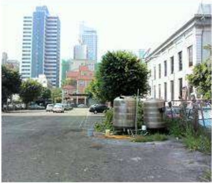
停車場水塔無蓋
