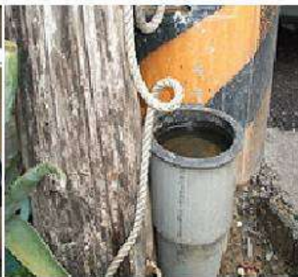
台電地下電纜引上管
