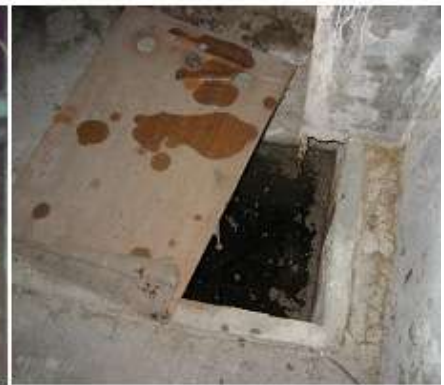
地下室污水池
