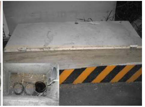
電信電纜管道
