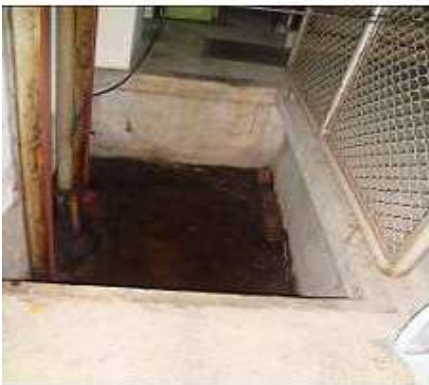
地下室之升降梯孔積水
