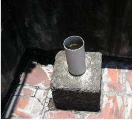
水泥樁上之水管
